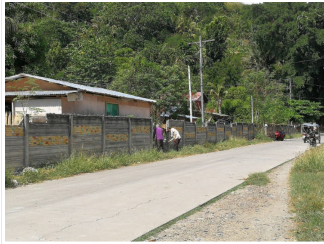
Ein Stück der Mauer wird abgebrochen...
